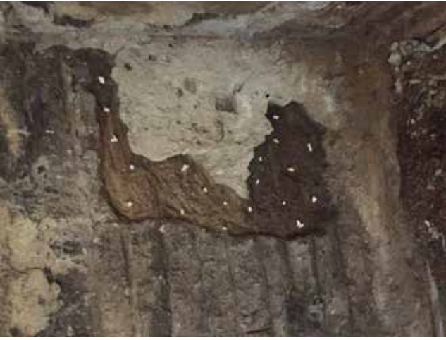
Ayanis – Açılan harç yatağının çamur harcını tutması ve bir bütünlük sağlaması için ahşap desteklerin çakılma işlemi
