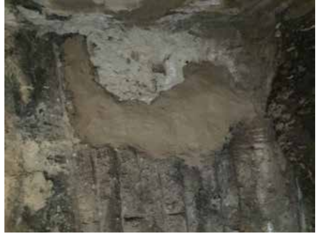
Ayanis – Restore işleminin temeli olan çamur harcı ile yatakların doldurulması
