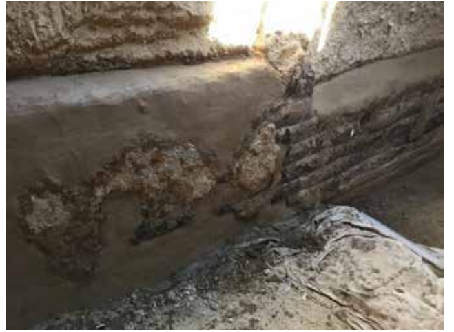
Ayanis – Uygulama sonrası: çamur harcı ve boyalı sıva tabakasının birbiri ile tutunarak bütünlük sağlaması ve kurumaya bırakılması
