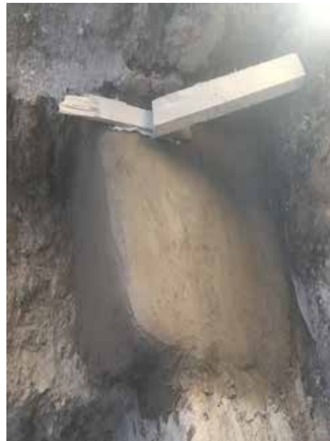
Ayanis – Restore uygulamalarından sonra kayma, kabarma vb. tahribatların oluşmasını önlemek için uygulanan ahşap levha desteği
