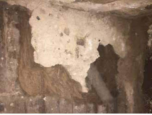
Ayanis – Restorasyon uygulaması için açılan harç yatağı örneği
