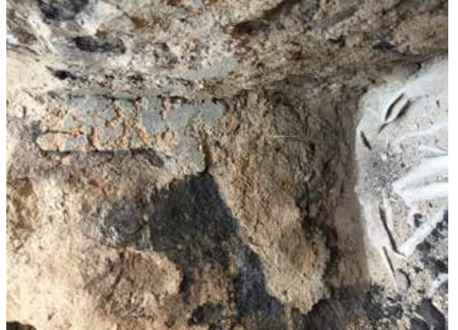
Ayanis – Podyumlu Salon'da bulunan, yangın ve doğal etkenlere maruz kalmış bozulmaya ve tahrip olmaya sebebiyet veren boyalı sıva tabakası
