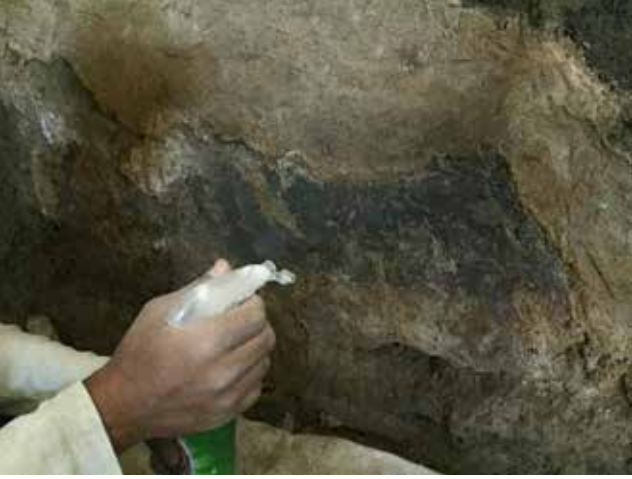
Ayanis – Sıva tabakasının bünyesinde mekanik dayanıklılık kazanması için uygulanan konsolidasyon işlemi
