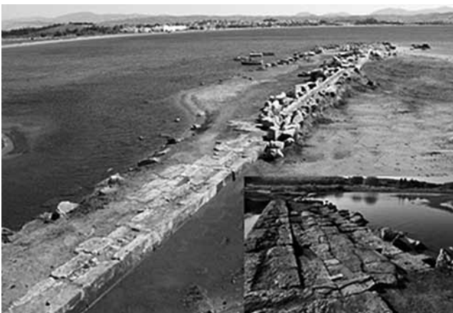
Resim 8 – Güney Liman İskelesi ve Dalgakıran
