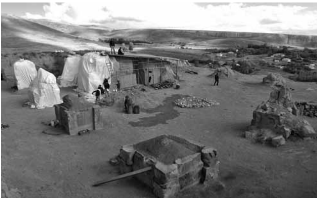
Van Ayanis Kalesi – Tapınak Alanı Koruma ve Onarım Çalışmalarından Genel Görünüm
