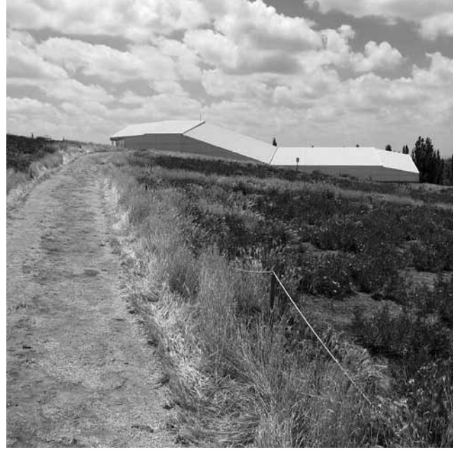
Resim 8: Çatalhöyük Güney Alanı Koruma Çatısı (M. Savrum-Kortanoğlu Arşivi)
