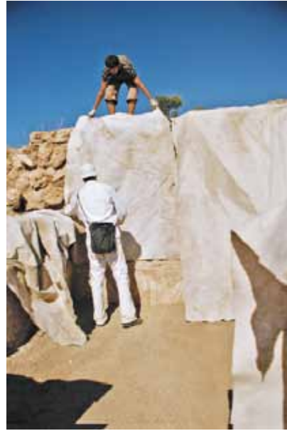
Hadrianoupolis – Jeotekstil Çalışmaları
