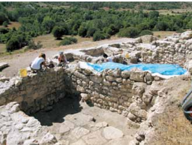
Hadrianoupolis – Yapı Duvarlarını Derzleme Çalışmaları
