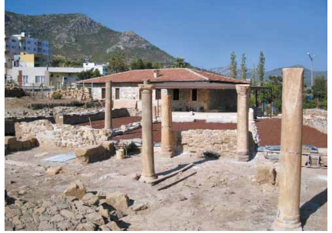
Kelenderis – Agora Bazilikası Onarım Sonrası Görünüşü
