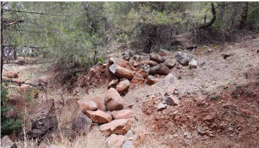
Res. 8 – Çiçektepe Mevkii'nde tahrip edilmiş Hitit duvarı
